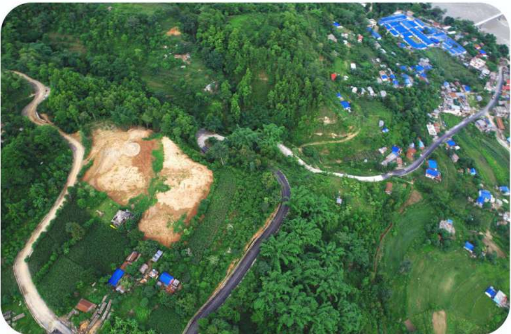
नवनिर्मित बुट्टार मकैसिड कालोपत्रे सडक, गण्डकी गाउँपालिका वडा नं. १, बुट्टार
