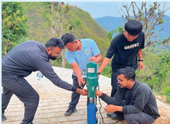
वडा गौरव योजना अन्तर्गत केउरेनी-छापथोक-केराबारी सडक खण्ड स्तरोन्नति योजनाको ढलान सडक (Rigid Pavement) को Core Cutter सहित अनुगमन कार्य
